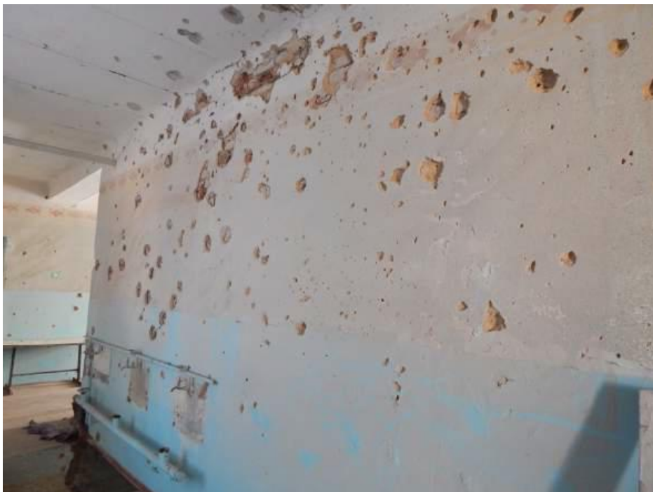
В здании школы №3
