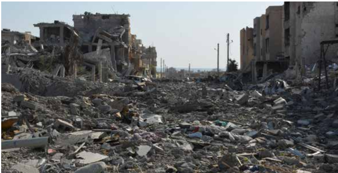
Вид на разрушенные здания после того, как бойцы Сирийских демократических сил установили контроль над Эр-Раккой. 22 октября 2017 г. © Юсеф Рабих Юсеф / EPA-EFE
