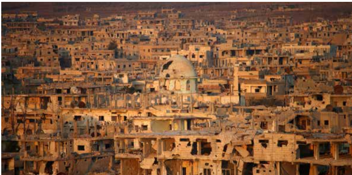
Поврежденные и разрушенные здания в городе Дарья на юге Сирии. 21 августа 2017 г.
