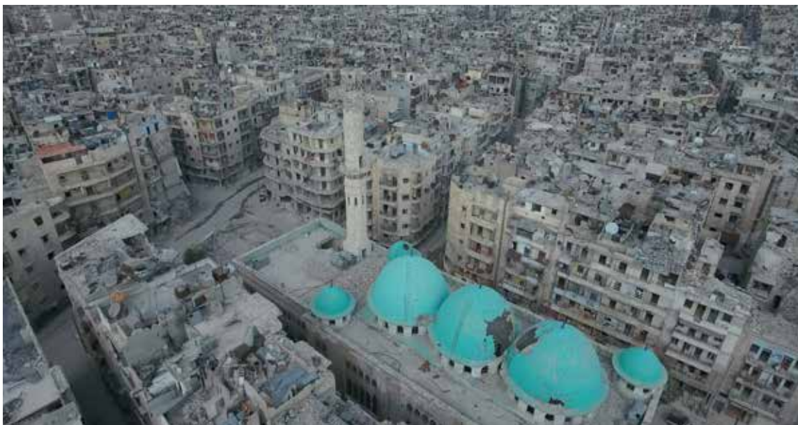
Разрушенные здания в городе Алеппо © Fly_and_Dive / Shutterstock
